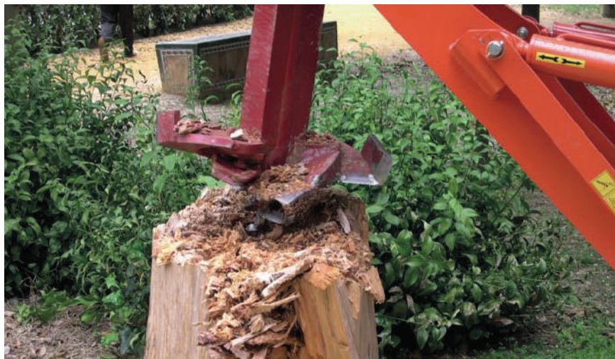
Figura 5. Destoconado de árboles a sustituir.
